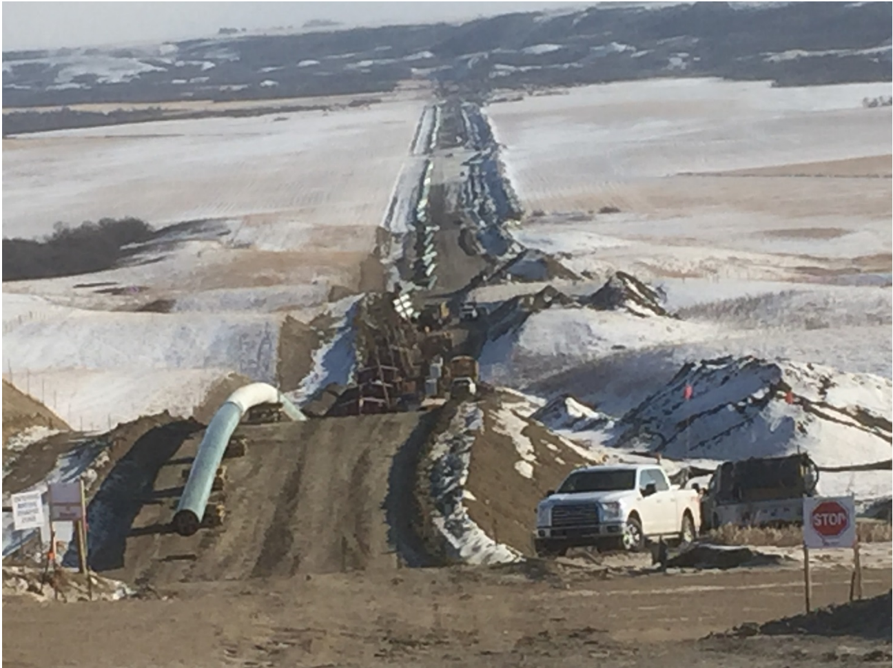
Qu'Appelle valley main welding crew
